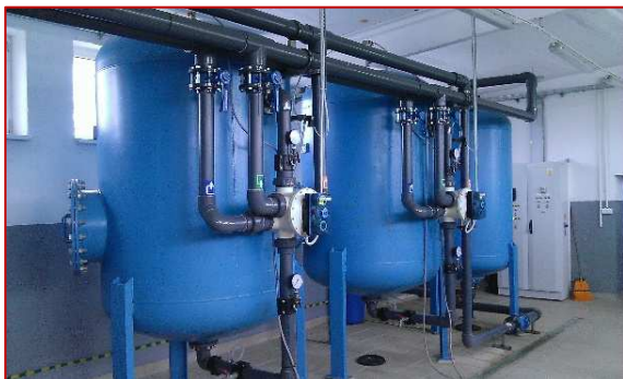
Fot. Wodociąg publiczny w Chotkowie, gm. Brzeźnica – urządzenia filtrujące w Stacji Uzdatniania.
