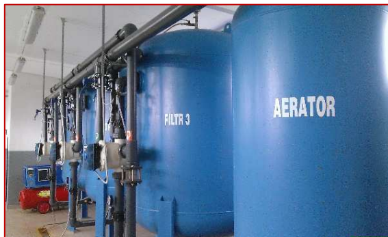
Fot. Wodociąg publiczny w Chotkowie, gm. Brzeźnica – urządzenia filtrujące w Stacji Uzdatniania.
