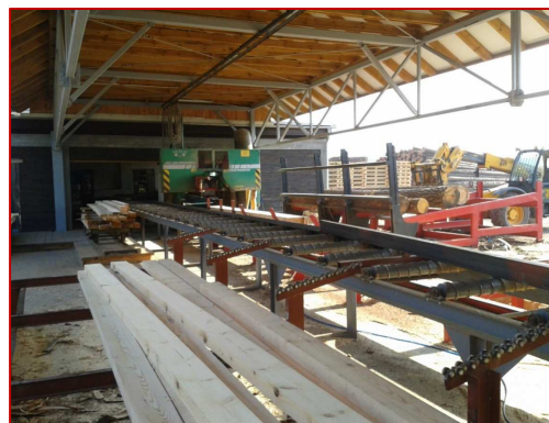
Zdjęcie. Wiata – Trak MEBOR taśmowy z odciągiem na trociny i podajnik wzdłużny na kłody w tartaku.
